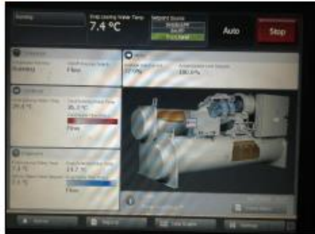
Şekil 4.5. 3 nolu chiller sistemi
