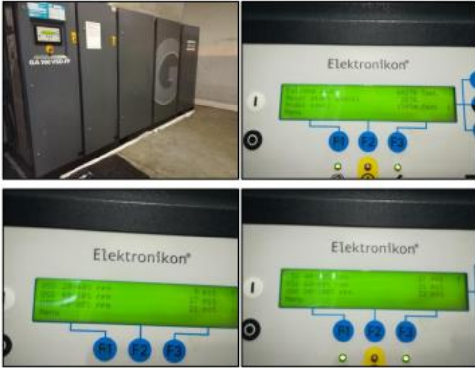
Şekil 6.6. Atlas Copco G160 VSD FF (kompresör 3) genel görünümü çalışma ekranları
