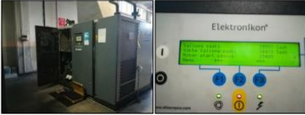
Şekil 6.4. Atlas Copco GA160 FF (kompresör 1) genel görünümü ve çalışma saati ekranı
