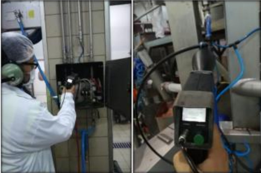
Şekil 6.10. Basınçlı hava kaçaqları ölçümleri
